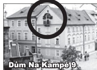
Vstup na balkónek
